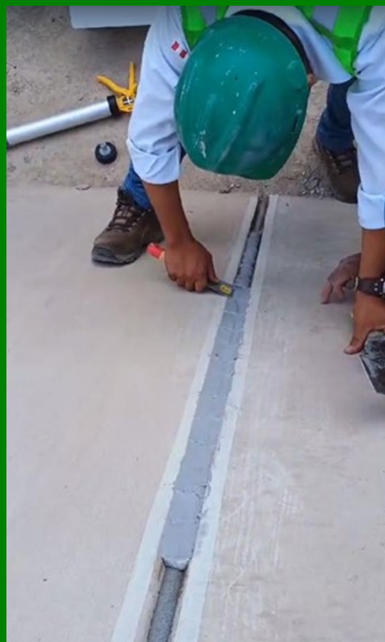
Imagen referencial-Aplicación del JUNTAFLEX 30-40 BI
