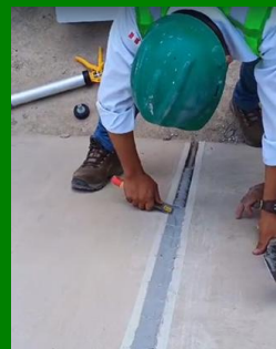
Imagen referencial- Aplicación del JUNTAFLEX 30-40 CPA
