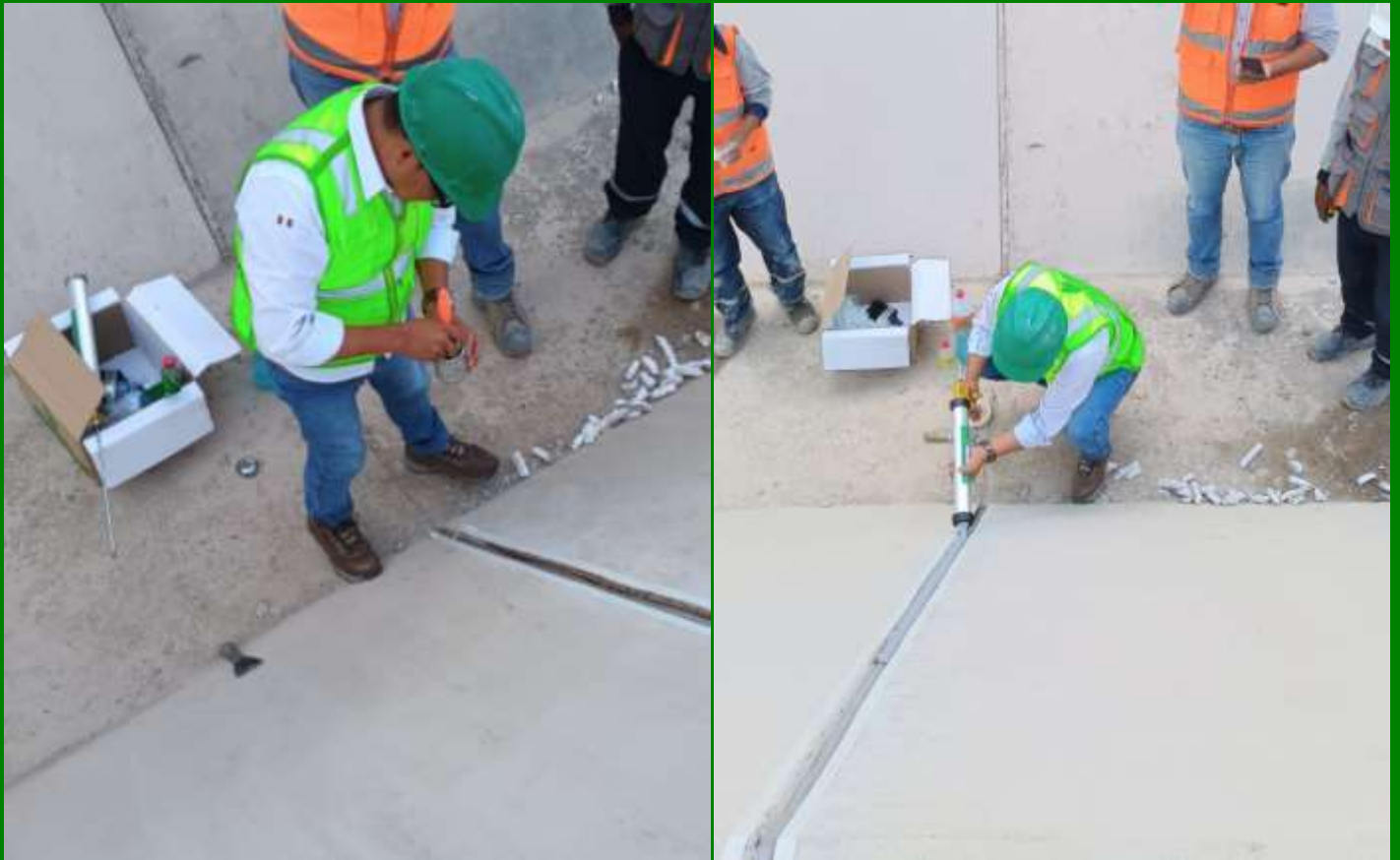
Imagen Referencial, Aplicación del JUNTA FLEX 30-50
