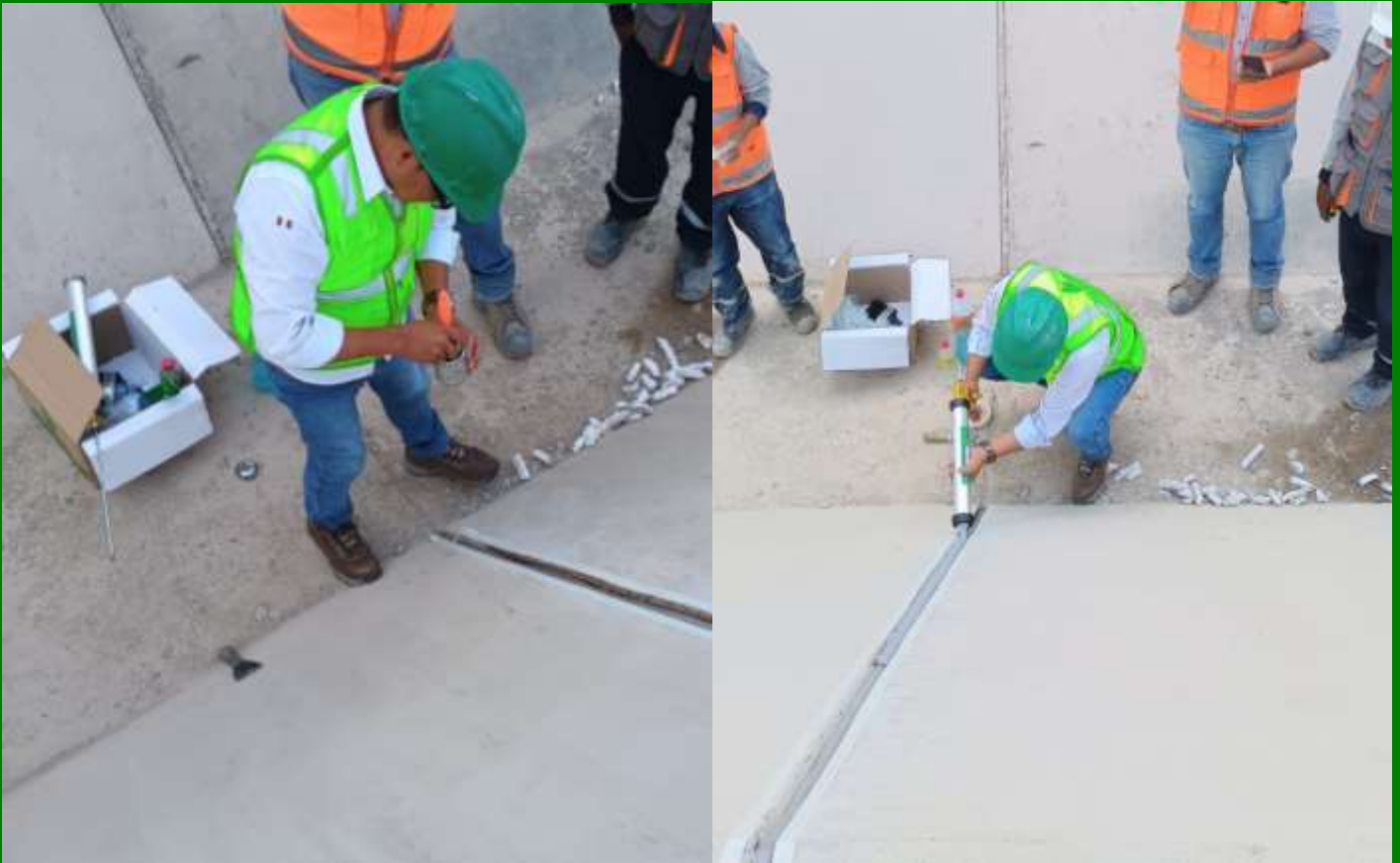
Imagen Referencial, Aplicación del JUNTA FLEX 30 - 40
