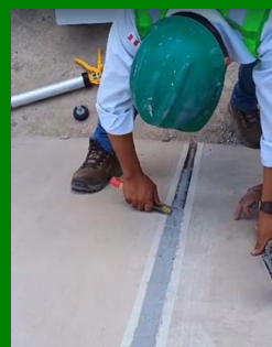
Imagen referencial-Aplicación del JUNTAFLEX BI II CPA
